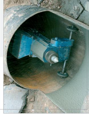
с электрическим или пневматическим приводом. Благодаря радиально установленным и имеющим гребешковый вид металлическим пластинам раствор разбрызгивается равномерно. В зависимости от условий проходимость при успешном проведении работ нанесённый раствор разглаживается специальными конусными парашютами или мастерками.
